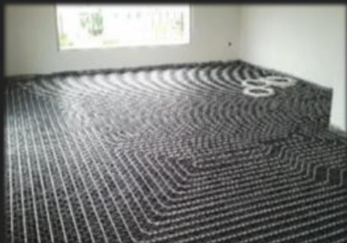
particolare riscaldamento a pavimento
